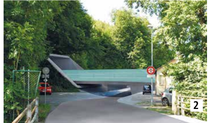
Tunnelportal Nord mit Unterführung Lebernweg
